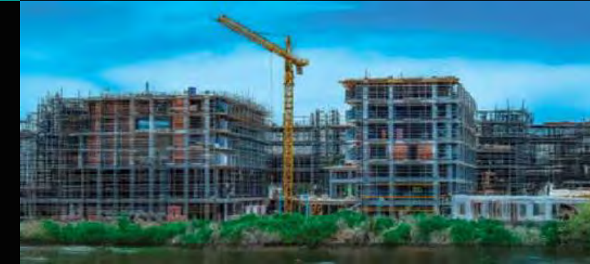
建筑工程与施工
