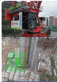
安達臣道石礦場R2-6及R2-7地盤公營房屋發展計劃建築工程
