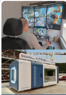
東涌第42區第一期及第二期公營房屋發展計劃建築工程
