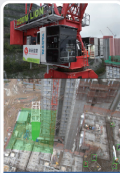
安达臣道石矿场R2-6及R2-7地盘公营房屋发展计划建筑工程
